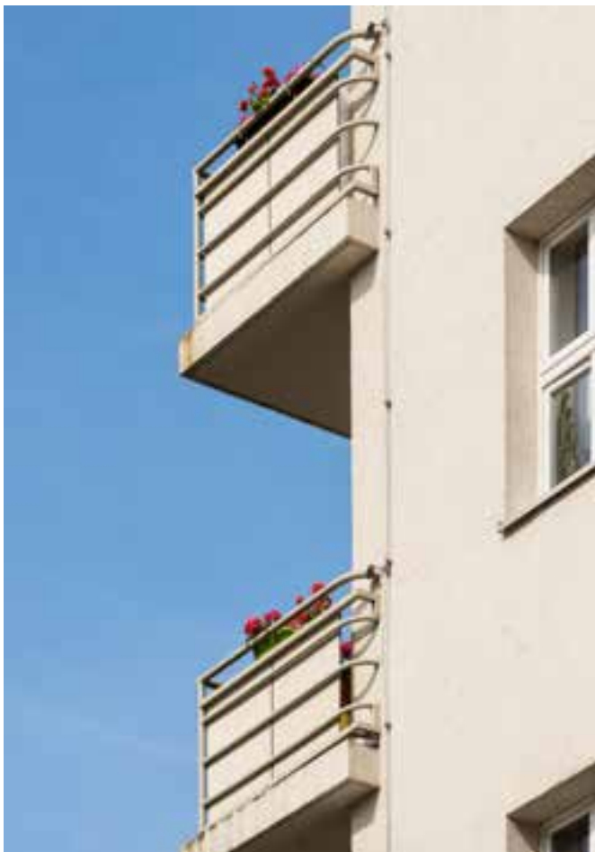
Gebäudeecke mit Balkonen
