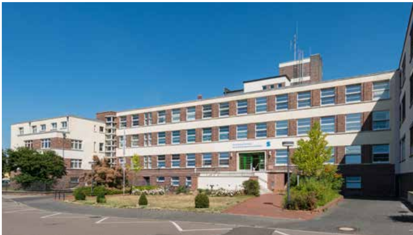
Ansicht des Hauptgebäudes von Südwesten
