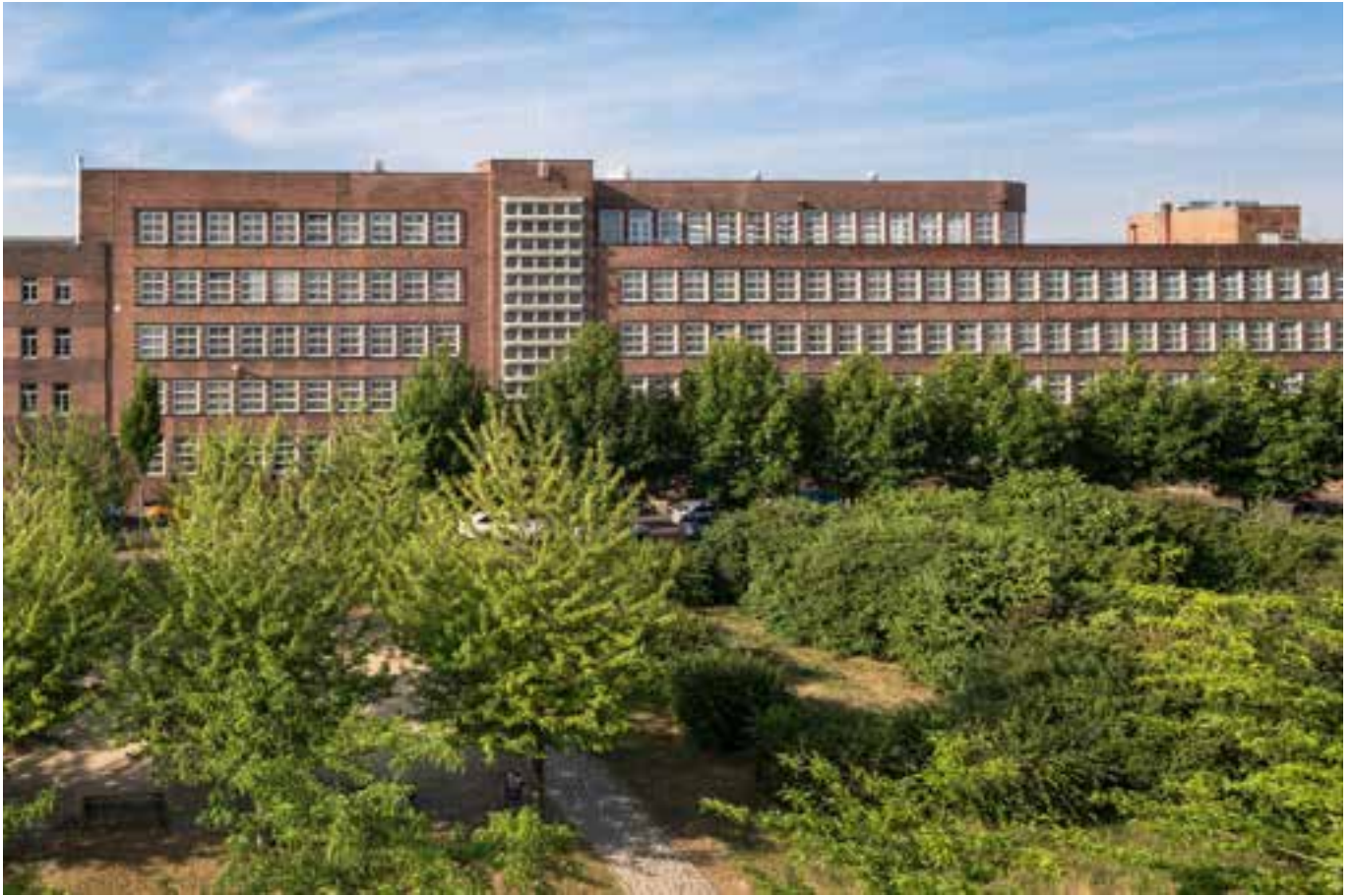
Gesamtansicht von Norden
