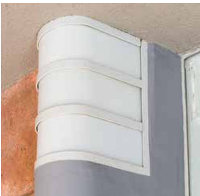
Lampendetail im Eingangsbereich
