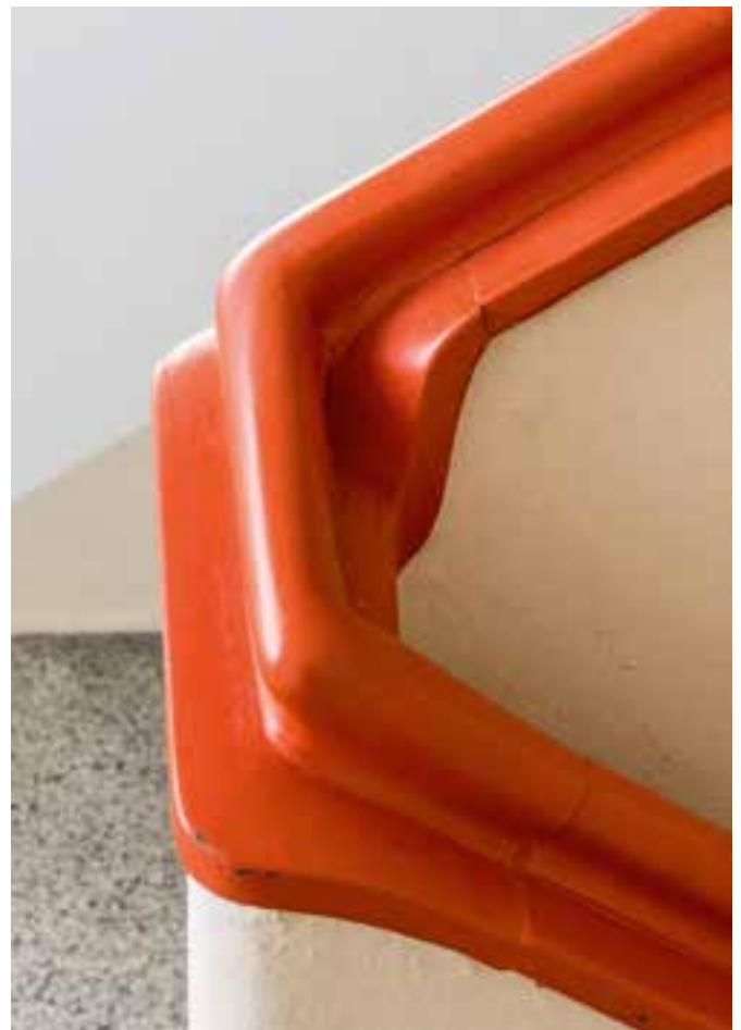
Detail aus dem Treppenhaus
