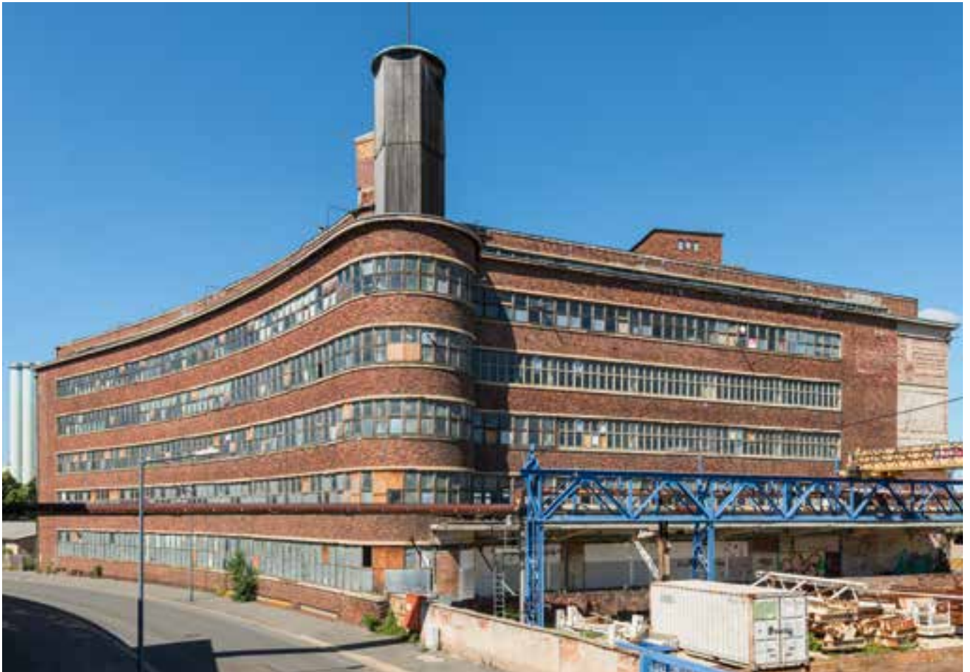
Fleischereigebäude von Südwesten
