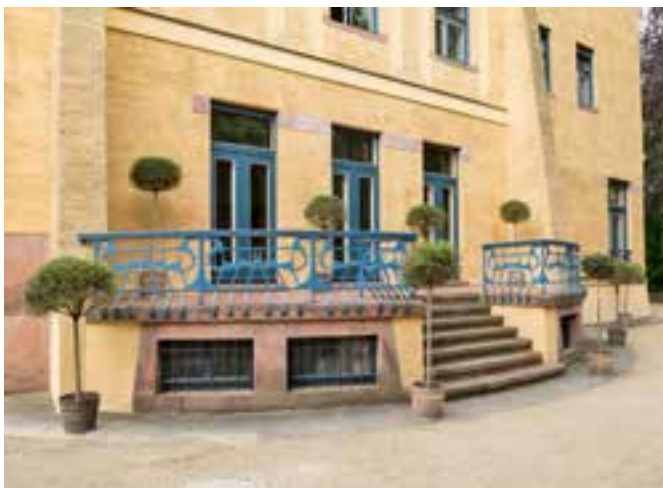
Terrasse an der Westfassade
