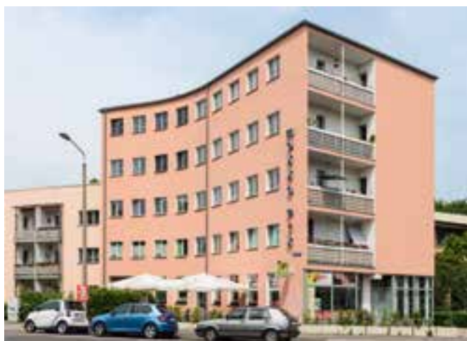
Ecke Industriestraße / Kopernikusstraße von Südosten
