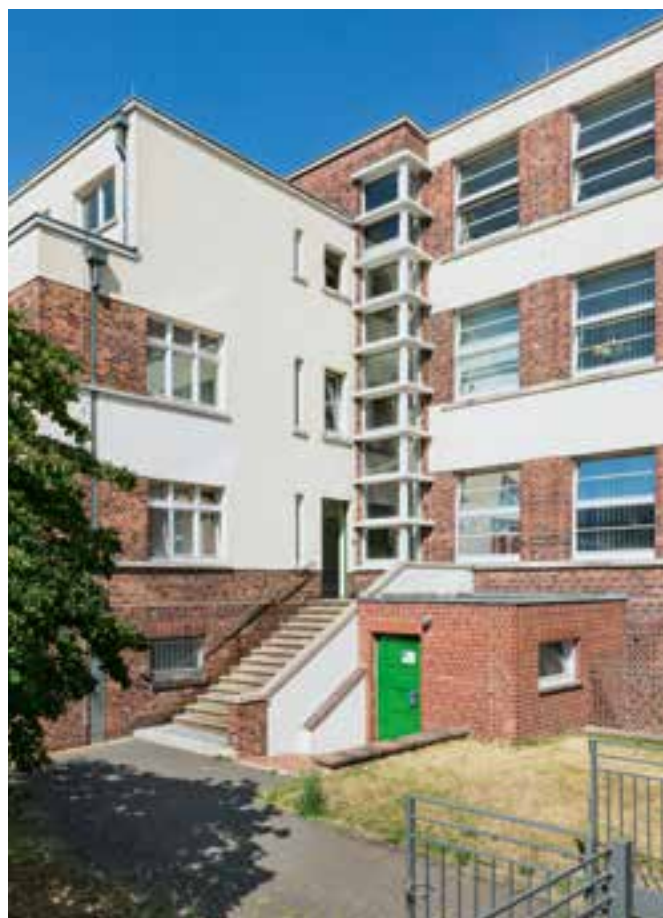
Detail des Hauptgebäudes von Südwesten
