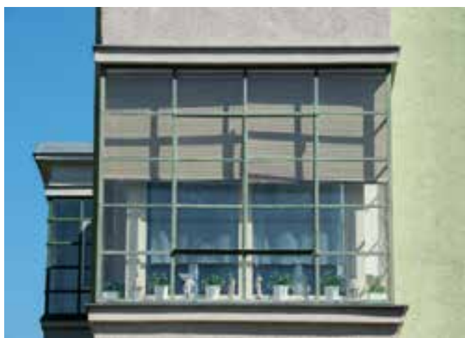
Detail am Norderneyer Weg von Süden
