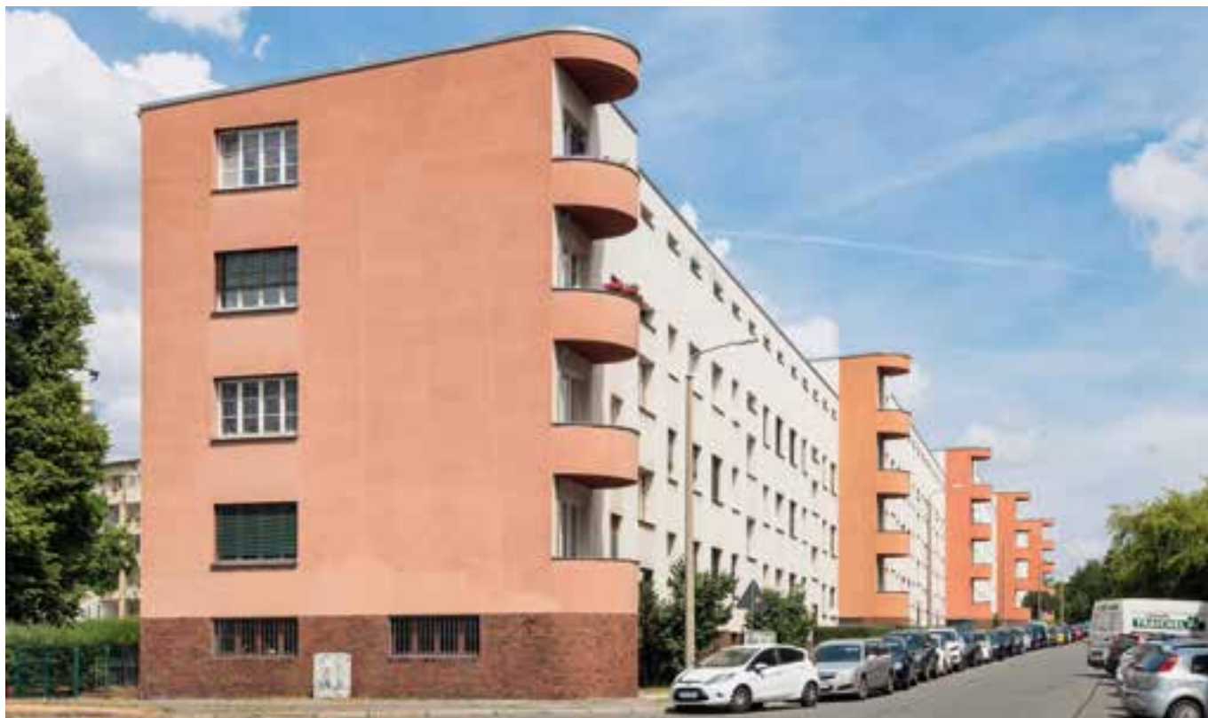
Blick in die Faradaystraße von Südosten
