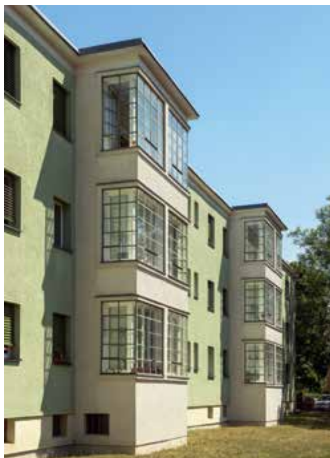
Rückseite am Norderneyer Weg von Nordwesten
