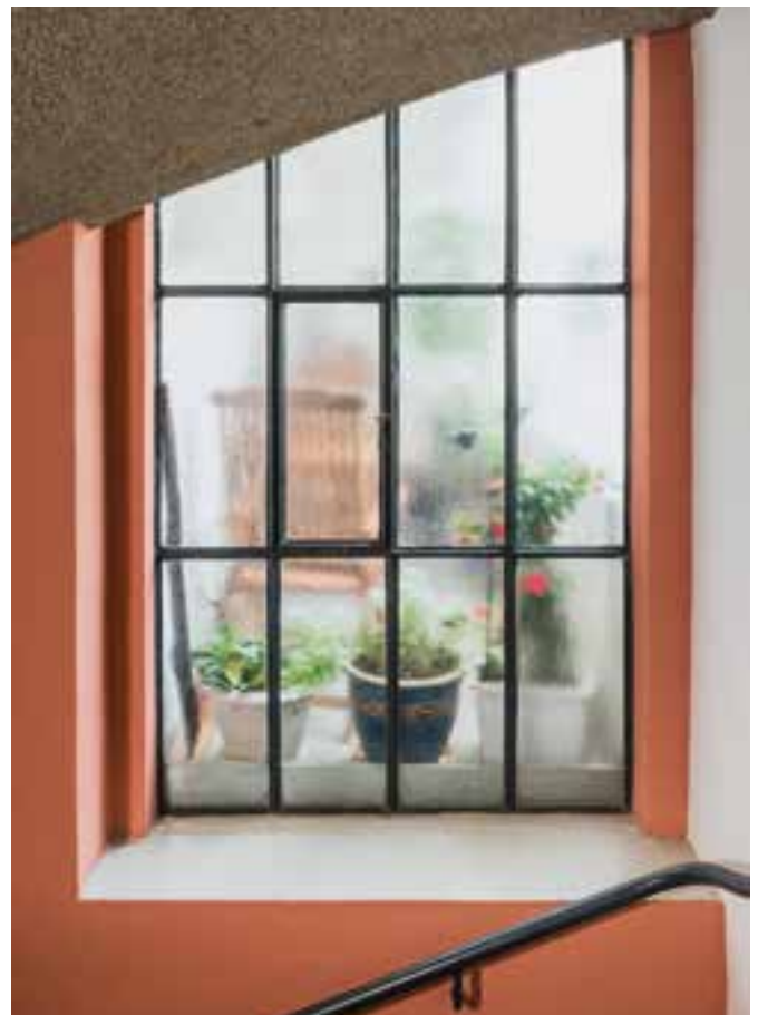
Fenster im Treppenhaus
