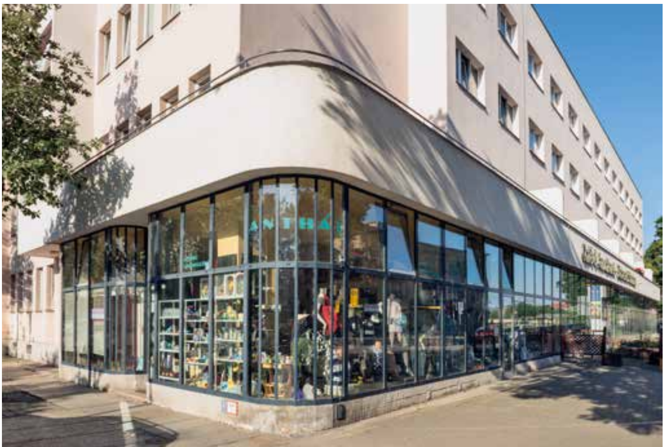
Eckgeschäft Rehefelder / Wurzener Straße von Nordosten
